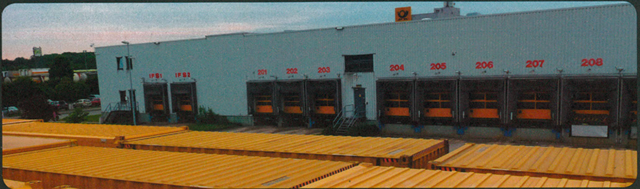
Die Endgeräte lassen sich gut in den Aussparungen der Container versenken.
